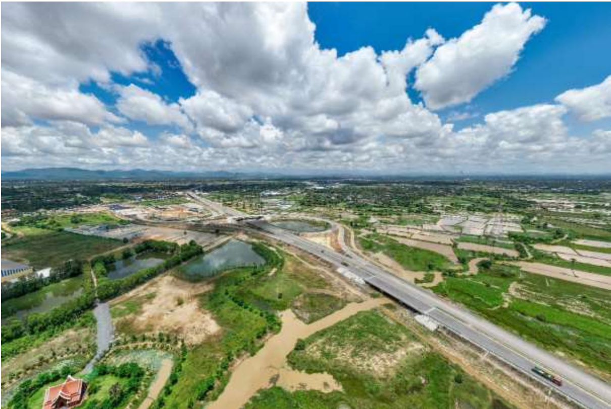
金港高速公路
